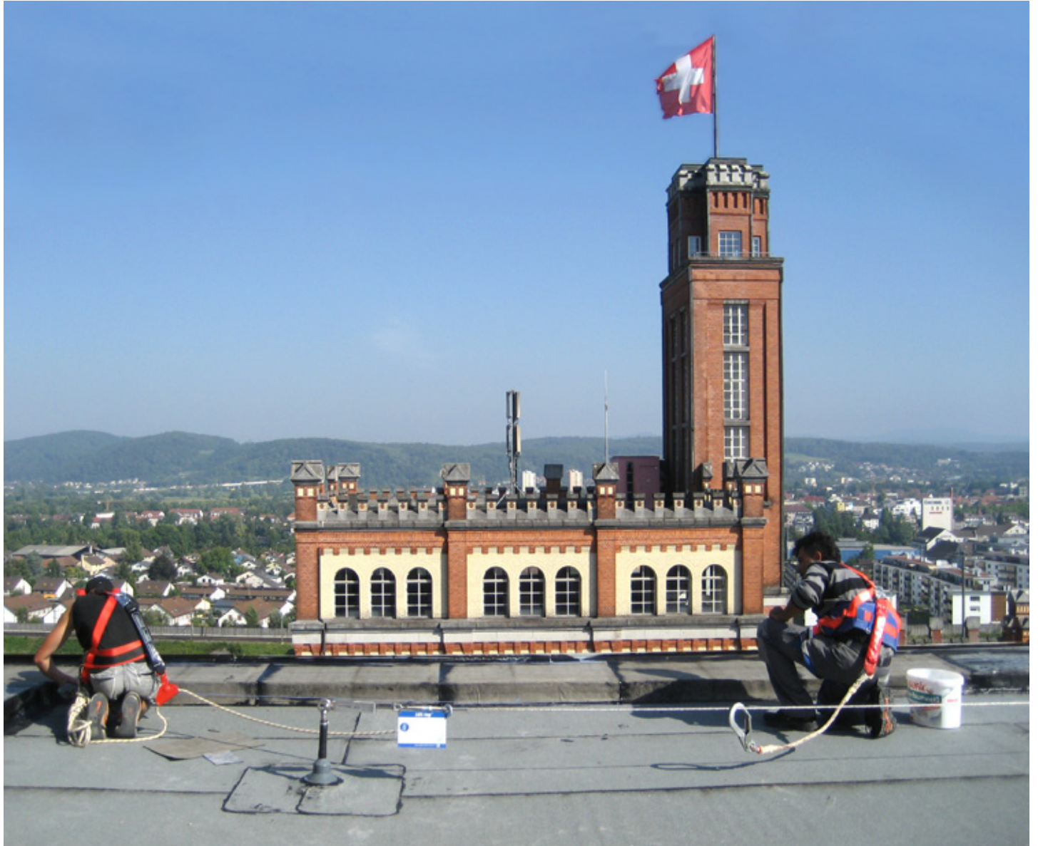
Beispiele von Sicherheitseinrichtungen auf Flach- und auf Steildächern
