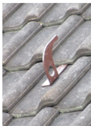
Beispiele von Sicherheitseinrichtungen auf Flach- und auf Steildächern
